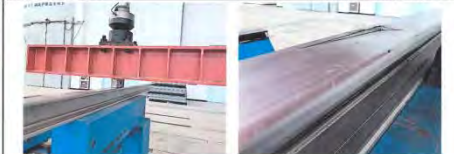
图1 中型边柱强度静载试验现场照片 图2 中型边柱强度静载试验边柱破坏照片 根据试验结果, 绘制力-位移曲线如下图3所示。
